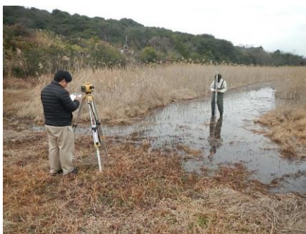
写真-1 測量調査
