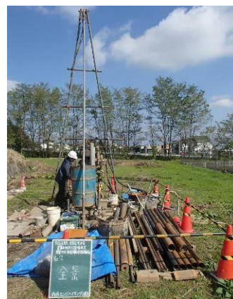
写真-2 地質調査
