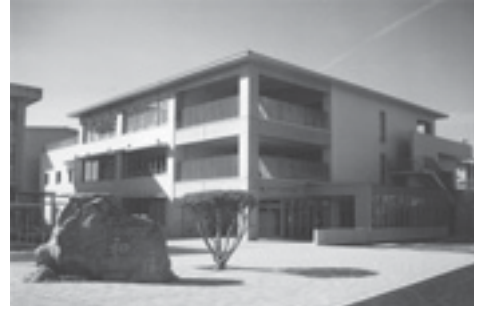
平成25年 榛東中学校新校舎完成
