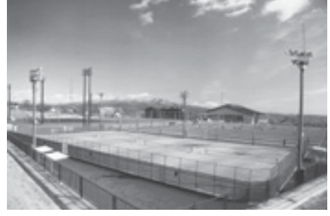
平成17年 総合グラウンド・アリーナ完成
