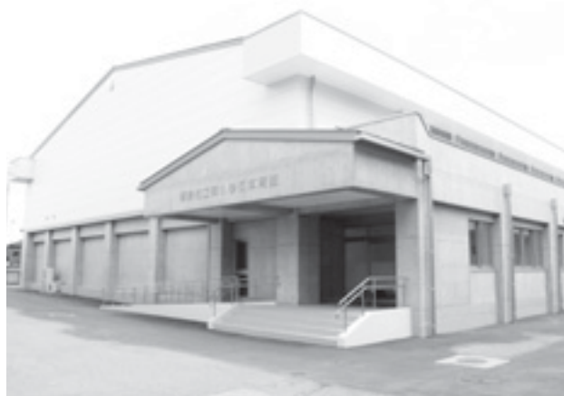
南小学校体育館
