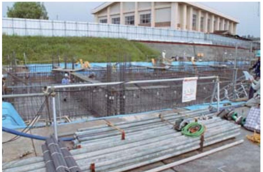
工事は2つの工区に分けられており、最初に着工されているA工区(特別教室棟)では、床や柱などのコンクリート打設が終わり、3階建ての外観が分かるようになりました(写真上段)。
