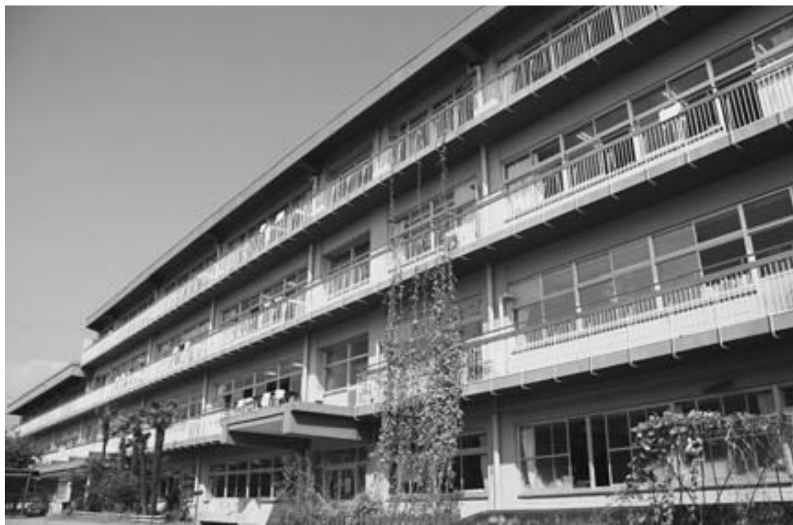
平成22年9月から平成24年2月までの工事期間で立て替えが予定されている榛東中学校の現在の校舎
