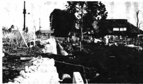
→9区地区道路改良工事
