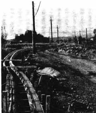
→山子田支線四八号改良工事(五区乙倉海戸地内)
