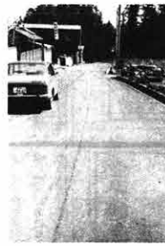
柳沢農道舗装工事
