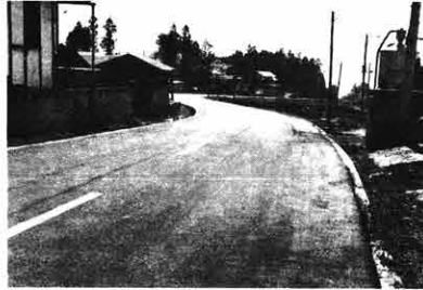
宮室農道舗装工事
