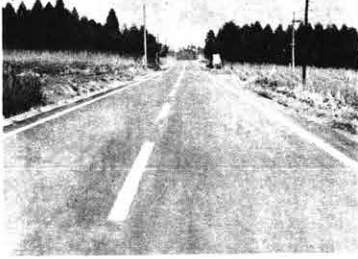
上野幹線舗装新設工事
