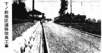
下ノ前地区道路改良工事
