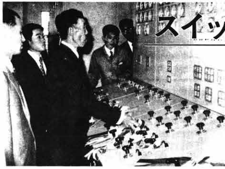
ポンプの起動開始
