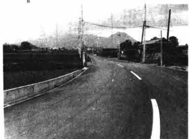
【常々と進む道路整備】
