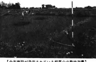
【今年建設が予定されている相馬小の敷地測量】
