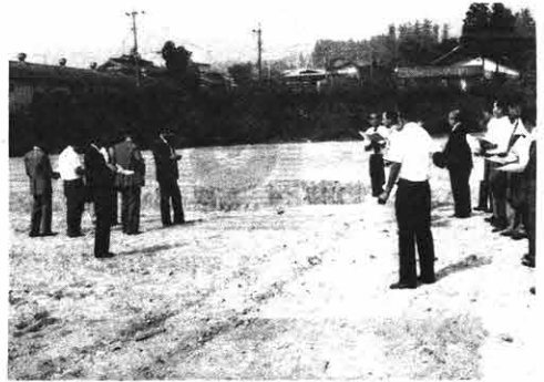
北小の建設について現場で協議する建設委員
