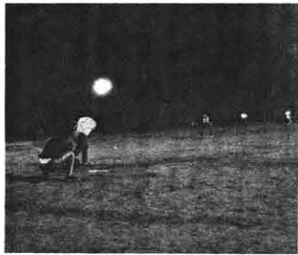
総合グラウンド夜間照明 照明48灯を設備 事業費 1,112万円
