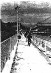
金古一広馬線舗装工事 延長 415.2㎡ 事業費 1,500万円
