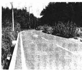
新井一遊人越線舗装工事 延長 840m 事業費 1,750万8千円
