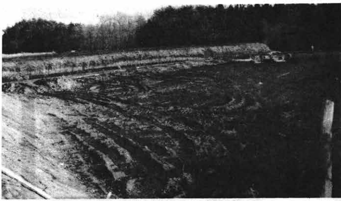
着々工事のすすむ養豚団地
