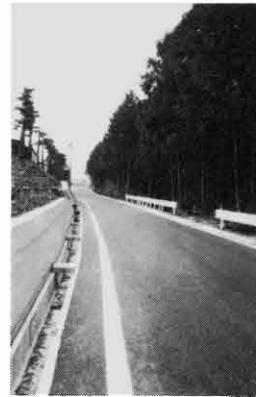
◀林道長岡支線307改良舗装 延長383.5m幅員5m 工事費2,231万円
