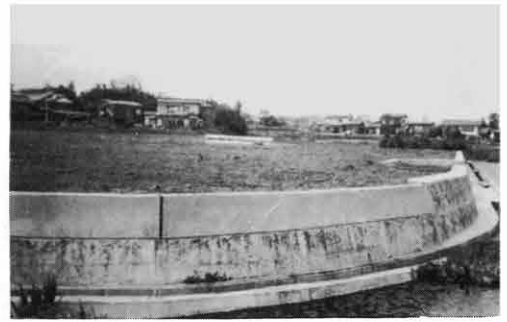
▲南幼稚園敷地造成工事 面積2,800㎡ 工事費622万円
