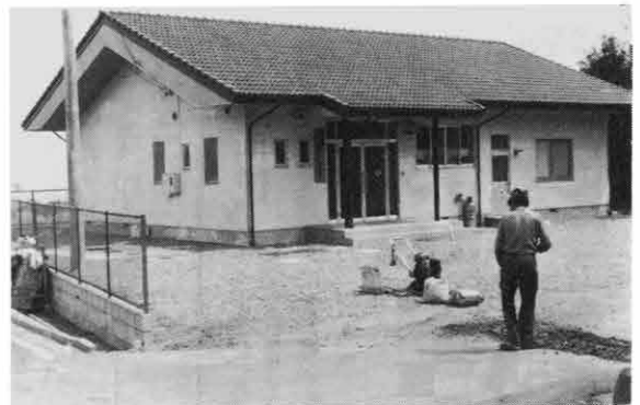
▲4区コミュニティー供用施設 面積141.63㎡ 工事費2,200万円
