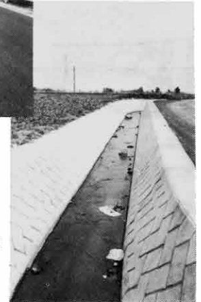
災害復旧事業▶ 15区牛池川 延長71.9m 工事費579万円
