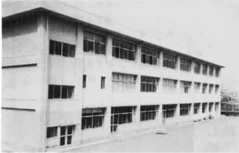
▲榛中特別教室棟 延面積1,713㎡ 総工事費2億4,000万円
