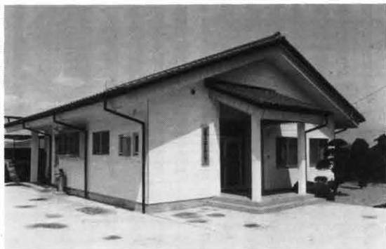
▲第2地区コミュニティー・センター（鉄骨造平屋建） 面積 139.59㎡ 事業費 2,130万円
