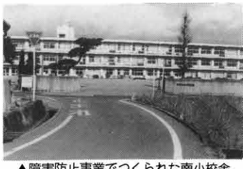
▲障害防止事業でつくられた南小校舎
