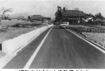
▲調整交付金により整備された9区地区内道路
