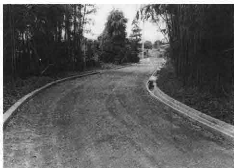
▲村道広馬場西部支線575号外1改良工事 延長 198m 工事費 972万円
