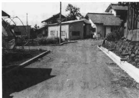
▼村道山子田支線73号外5および64号改良工事 延長 713.7m 工事費2,500万円
