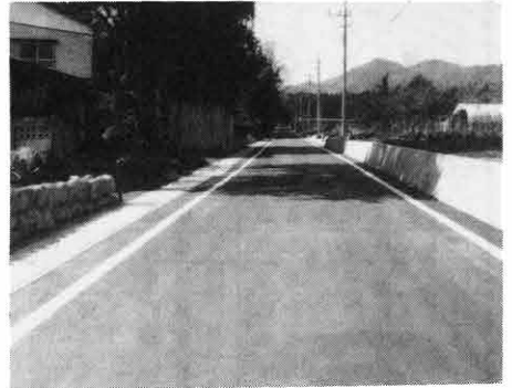
◀広馬場西部支線九九号拡幅改良工事 幅員四㊦、延長一五九㊦、橋梁一基
