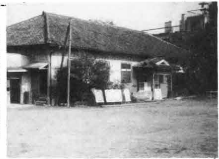
▲解体された旧公民館建物
