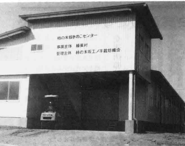
▲農林業地域改善対策事業 柿の木坂工ノ牛茸栽培施設新築工事、鉄骨造一部2階建延べ床面積1,274.45㎡
