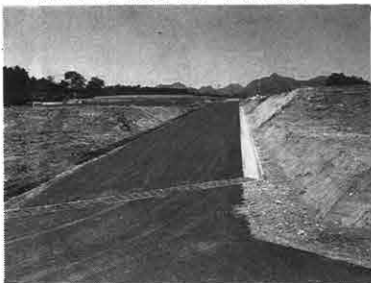
▼笹熊地区土地改良事業（面的整備）
