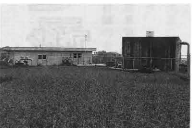
写真10 下新井機場新設工事
