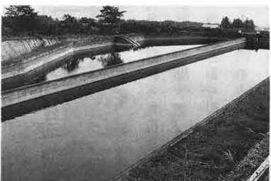
写真9 梨子木貯水池新設工事
