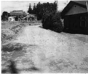
▲①村道八之海道33号線外2②改良舗装③4m④306m
