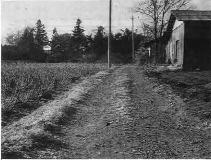
路線名 宿・井戸尻地区内農道 (広馬場地内) 工事内容 改良舗装 幅員・延長 5m幅 295m 工事費 1,480万円 工期 昭和63年1月25日～昭和63年3月25日
