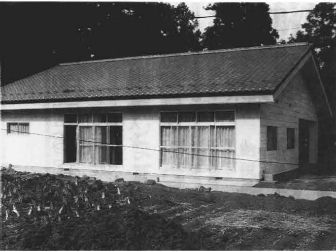
▲完成した7区コミュニティセンター
