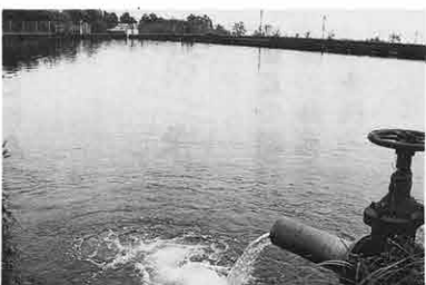
写真4 南部貯水池新設工事
