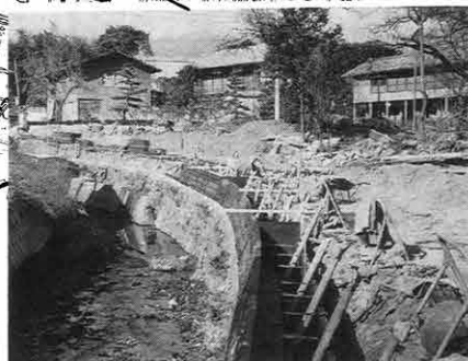
路線名 乙倉海戸15号線 (山子田地内) 工事内容 改良舗装 幅員・延長 4m幅 180m 工事費 590万円 工期 昭和62年12月28日～昭和63年3月15日
