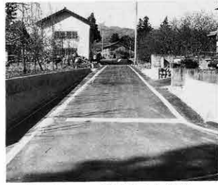
▲①村道上サ3号線②改良舗装③4m④95m
