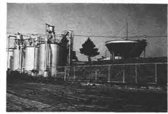
▲上水道浄水場
