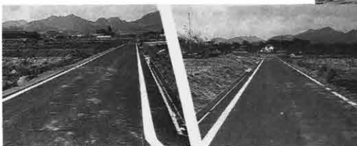
▲宿地区土地改良事業 （道路舗装）
