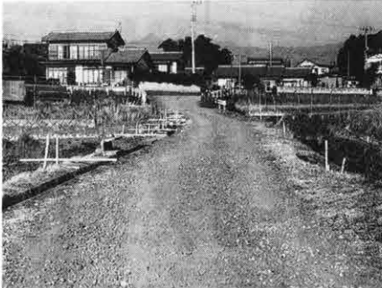
路線名 宮室・下ノ前地区内農道 (広馬場地内) 工事内容 舗装 幅員・延長 4m幅 267m 工事費 800万円 工期 昭和62年12月28日～昭和63年3月20日
