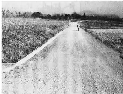
路線名 高塚5号線外3 (新井地内) 工事内容 改良舗装 幅員・延長 5m幅 528.28m 工事費 1,650万円 工期 昭和63年1月18日～昭和63年3月28日
