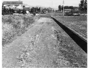
▶①川端地区小規模土地改良事業②改良舗装③4m④100m
