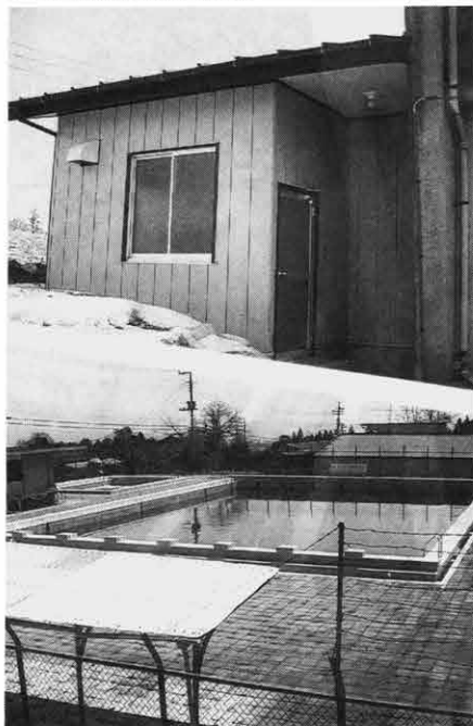
▲村民プール改修工事
