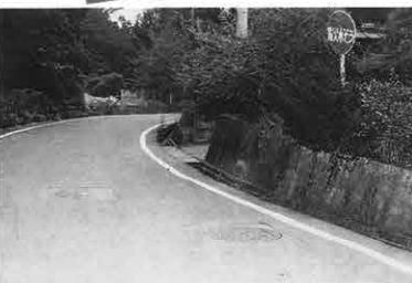
写真1 防火水槽新設工事
