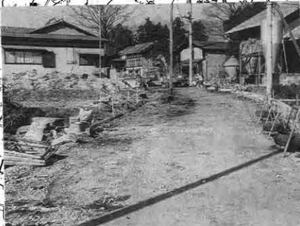
路線名 堀の内2号線外2 (新井地内) 工事内容 改良舗装 幅員・延長 5m幅 372.5m 工事費 1,420万円 工期 昭和62年12月10日～昭和63年3月25日
