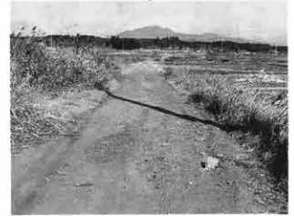
▲①小規模土地改良事業・中組農道②改良舗装③4m④210m
