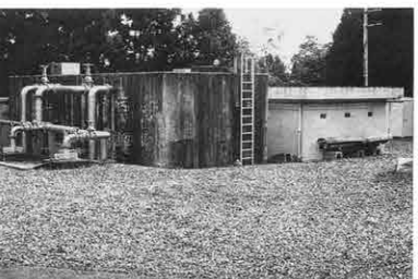
写真11 長岡機場新設工事
