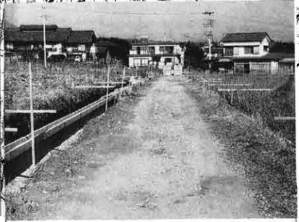
路線名 御堀地区内農道 (山子田地内) 工事内容 舗装 幅員・延長 4～5m幅 298.7m 工事費 670万円 工期 昭和62年12月10日～昭和63年3月25日
