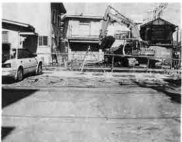
▲舗装が計画されている消防詰所前
