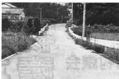
写真7 道路改良舗装工事
