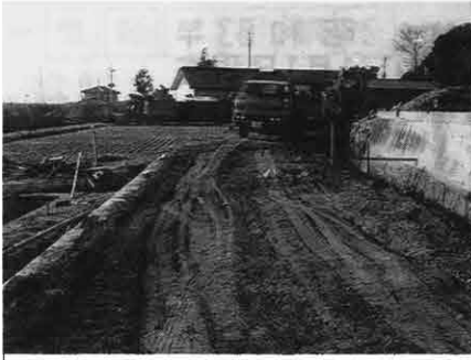
路線名 南4号線外1 (広馬場地内) 工事内容 改良舗装 幅員・延長 4m幅 工事費 830万円 工期 昭和62年12月1日～昭和63年3月15日
