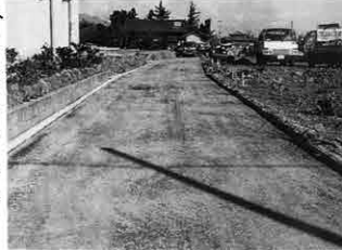
▶①村道十日市1号線外②改良舗装③4m④330m
