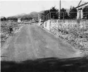
▲①布海道地区内農道②改良舗装③4m④173.3m
