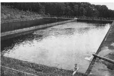
写真5 北部貯水池新設工事
