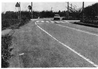
▲事故が多い広金農道と井戸尻線の交差点
