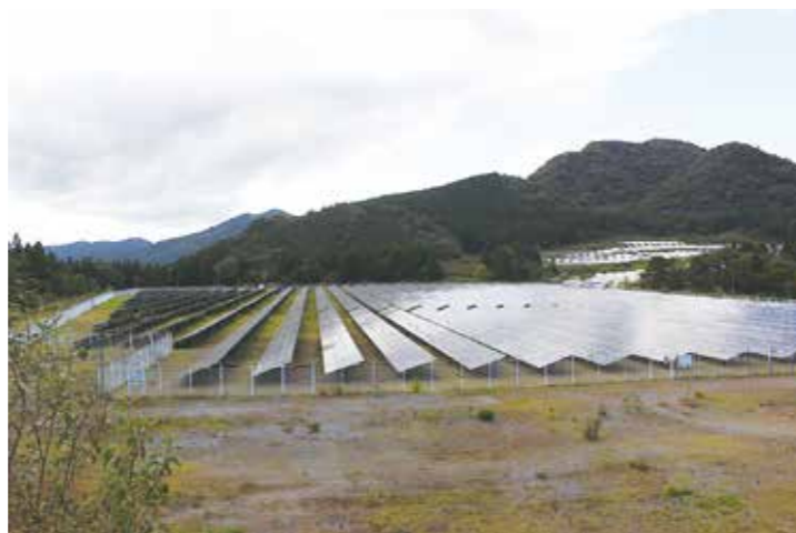
不適切な事務処理が行われた造成地のスラグ撤去
