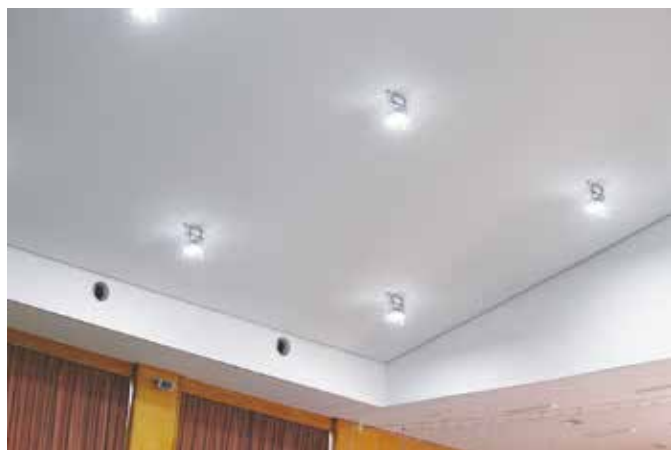
改修工事が完了した中学校講堂
