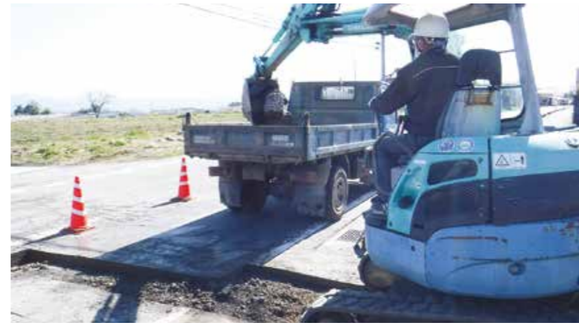
漏水箇所の管を新しく
