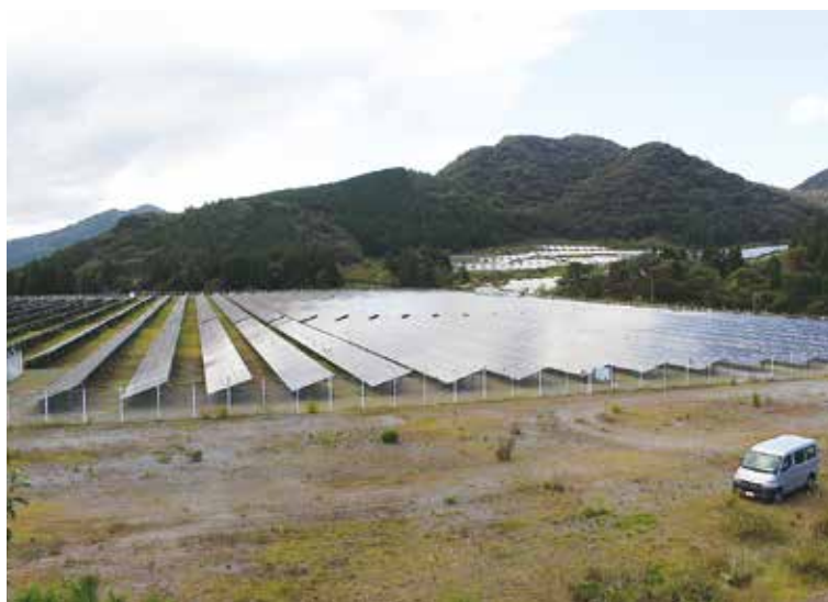
スラグ碎石に関する環境調査中の榛東ソーラーパーク
