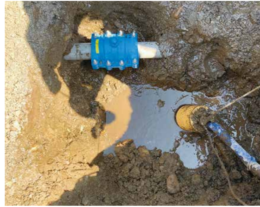
水道の漏水箇所を発見し復旧工事を
