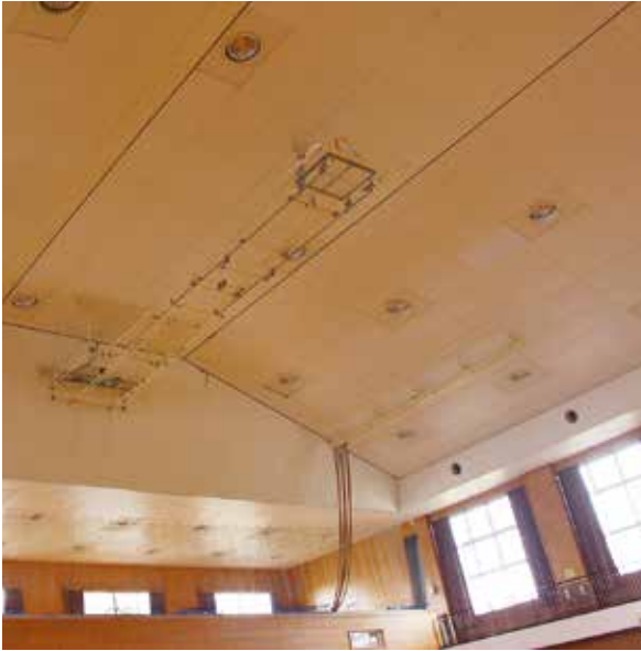
中学校講堂の天井改修工事（耐震化）
