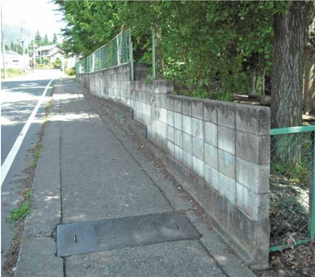
ブロック塀の改修工事
