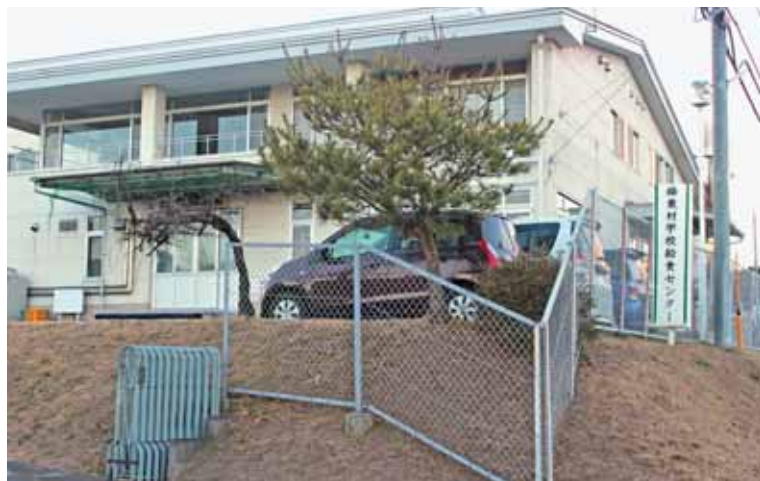
給食センターの老朽化が心配される
