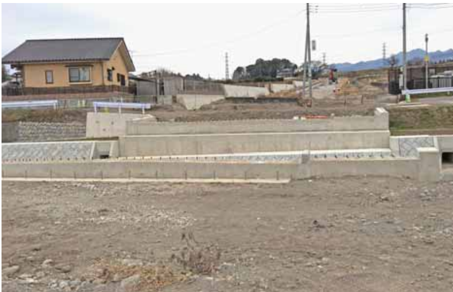
完成が望まれる新保・大藪線改良舗装工事
