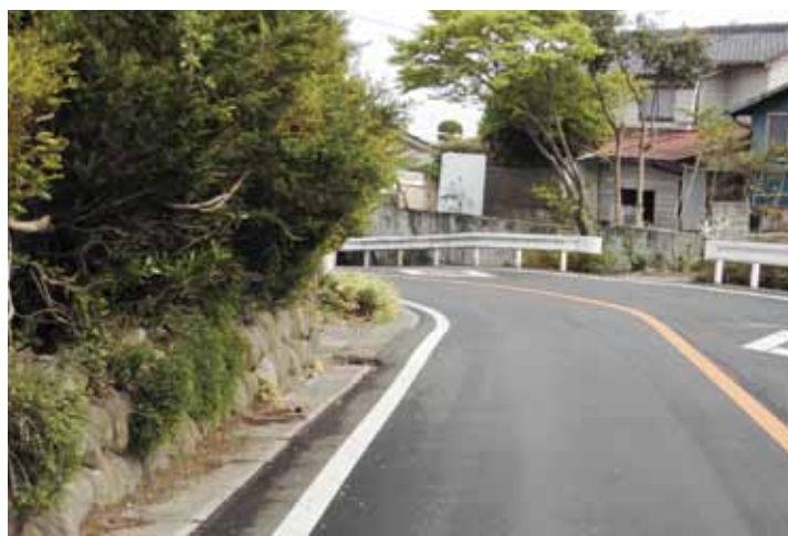
カーブの多い危険箇所
