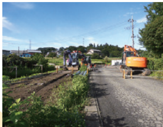
第2号計画道路改良舗装工事（6区・新保）
