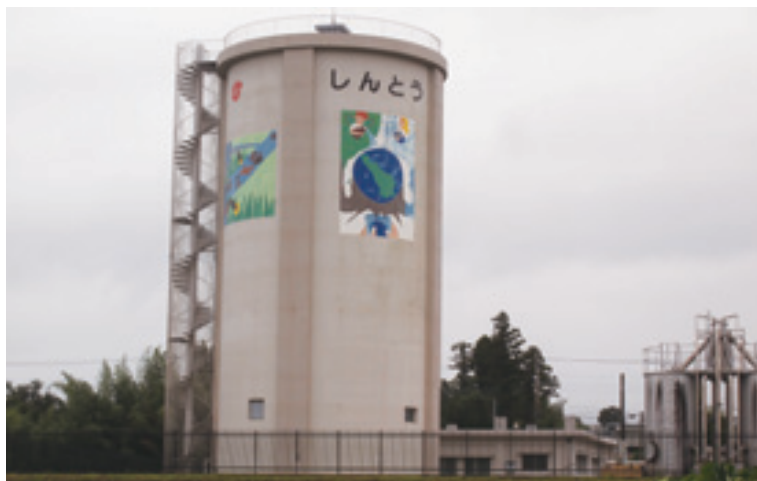
村民の飲料水を支える新井浄水場
