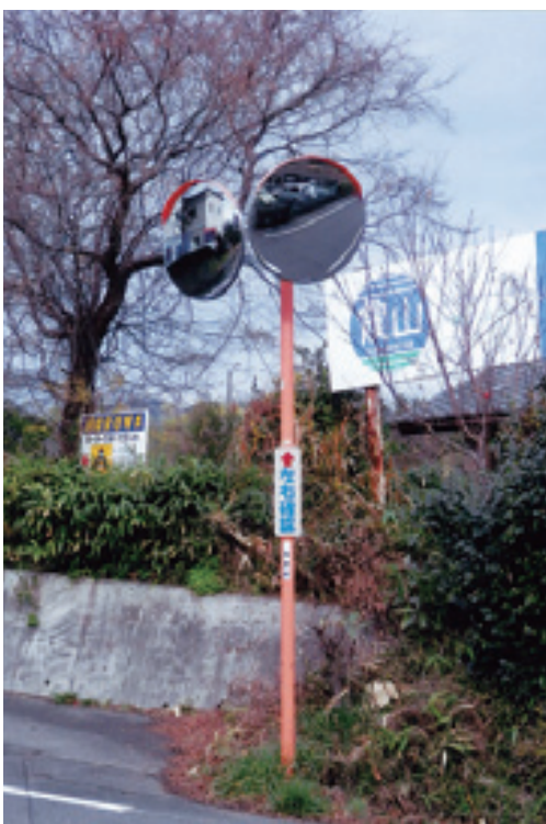
点検済みのカーブミラー
