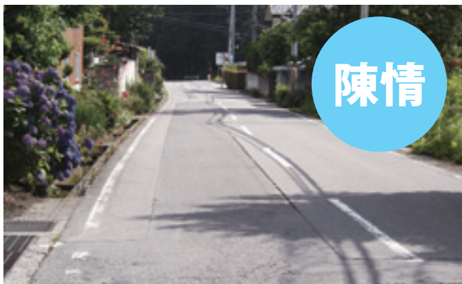
側溝の蓋がない通学路
