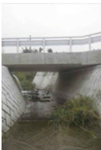
点検が終了した橋梁
