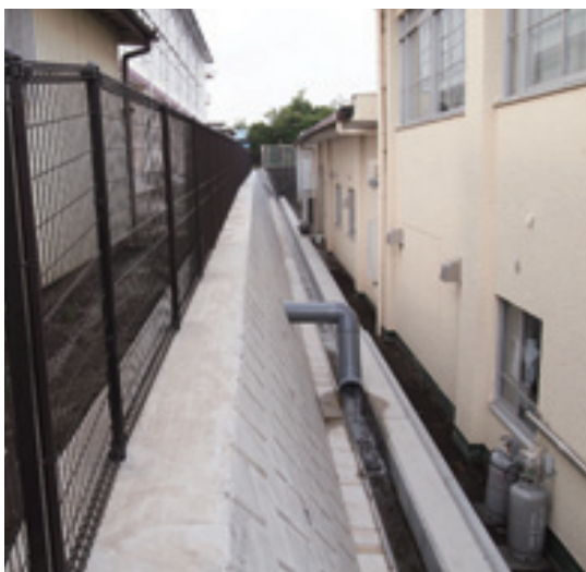
事故繰越しとなった北小学校擁壁工事
