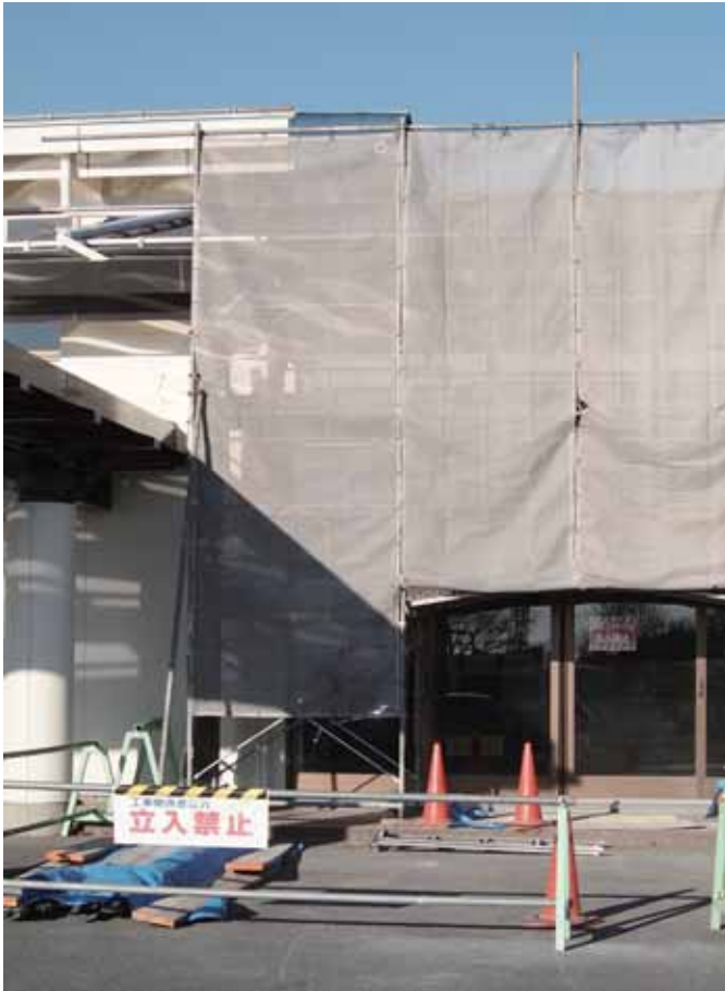
改修中の南部コミセン
