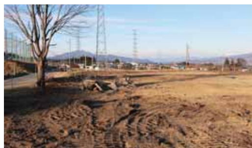
工事始まる (新井緑地公園)
