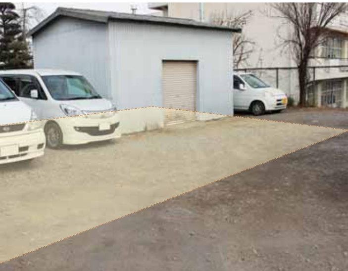
▲北幼稚園裏側の預り保育室建設予定地（12月17日現在）
