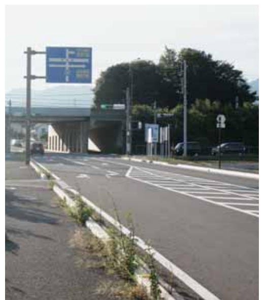
上毛大橋延伸道路
