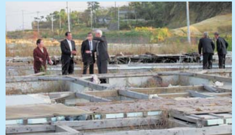
津波による被災現場
