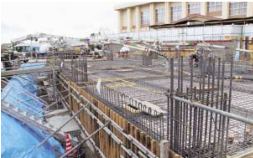
▲ 中学校の基礎工事
