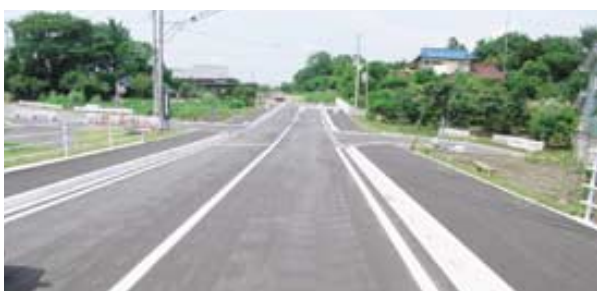
バイパス工事風景
