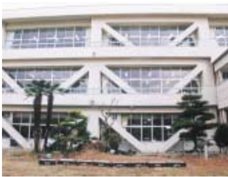
▲南小へ取りつける耐震補強ピタコラム工法
