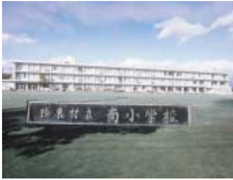
▲耐震工事が行なわれる南小
