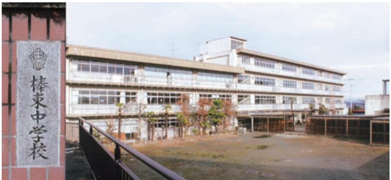
建て替予定の校舎
