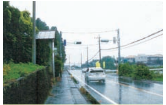
取付完了の信号機
