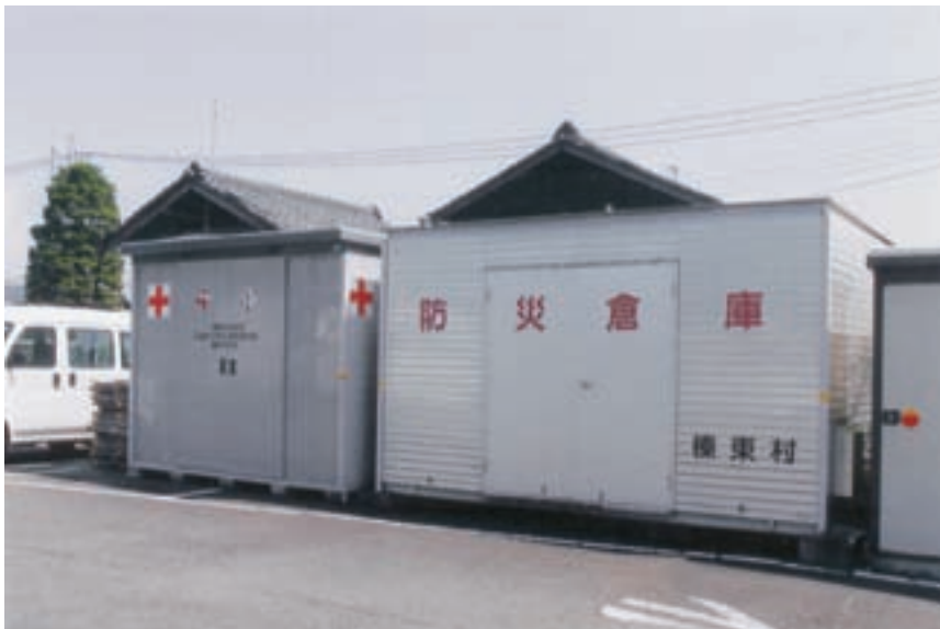
防災倉庫設置
