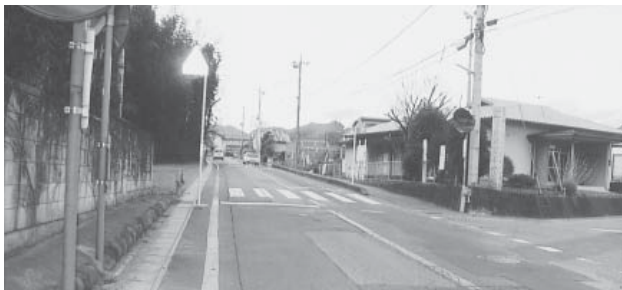
▶広金線舗装工事1,070m (岩崎建設)
