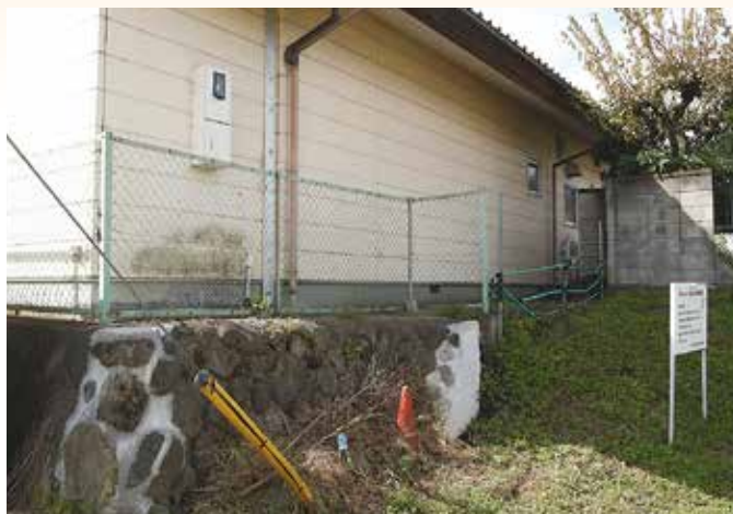
改修するフェンス（1区コミュニティセンター）
