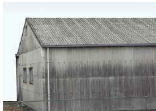
石綿含有スレート波板（屋根・外壁）
