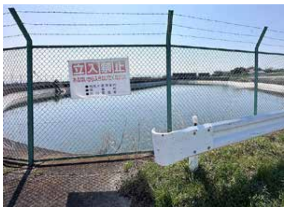
点検予定の稲葉貯水池（広馬場）
