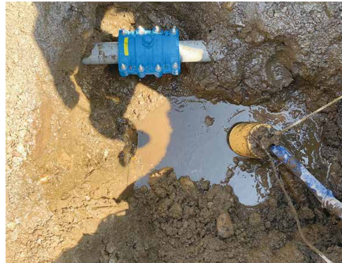
漏水修繕工事（令和4年度は75件で、総額738万円でした）
