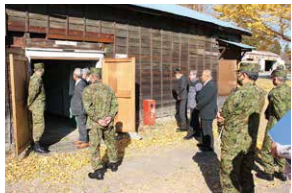
駐屯地内の老朽化した施設を視察
