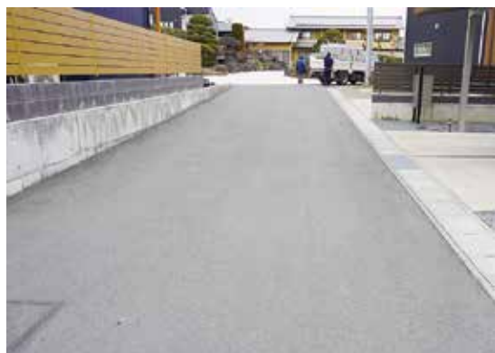
寄付された道路
