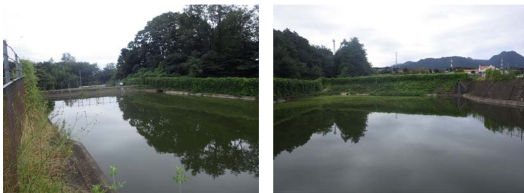
写真-1 大宮貯水池の状況
