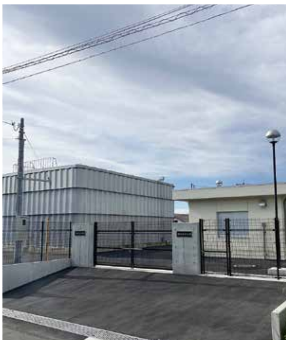
新 北部浄水場
