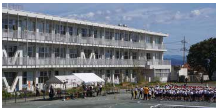
南小学校長寿命化改修工事完成
