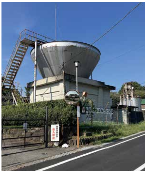
旧 北部浄水場
