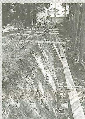
生活道路の改良（3区地内）
