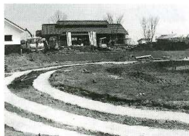
建設が進められているふるさと公園。
