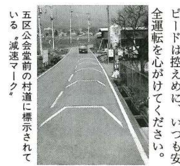
五区公会堂前の村道に標示されて いる「減速マーク」
